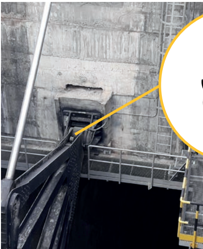
IT9420 Transductor de ángulo apertura compuerta
